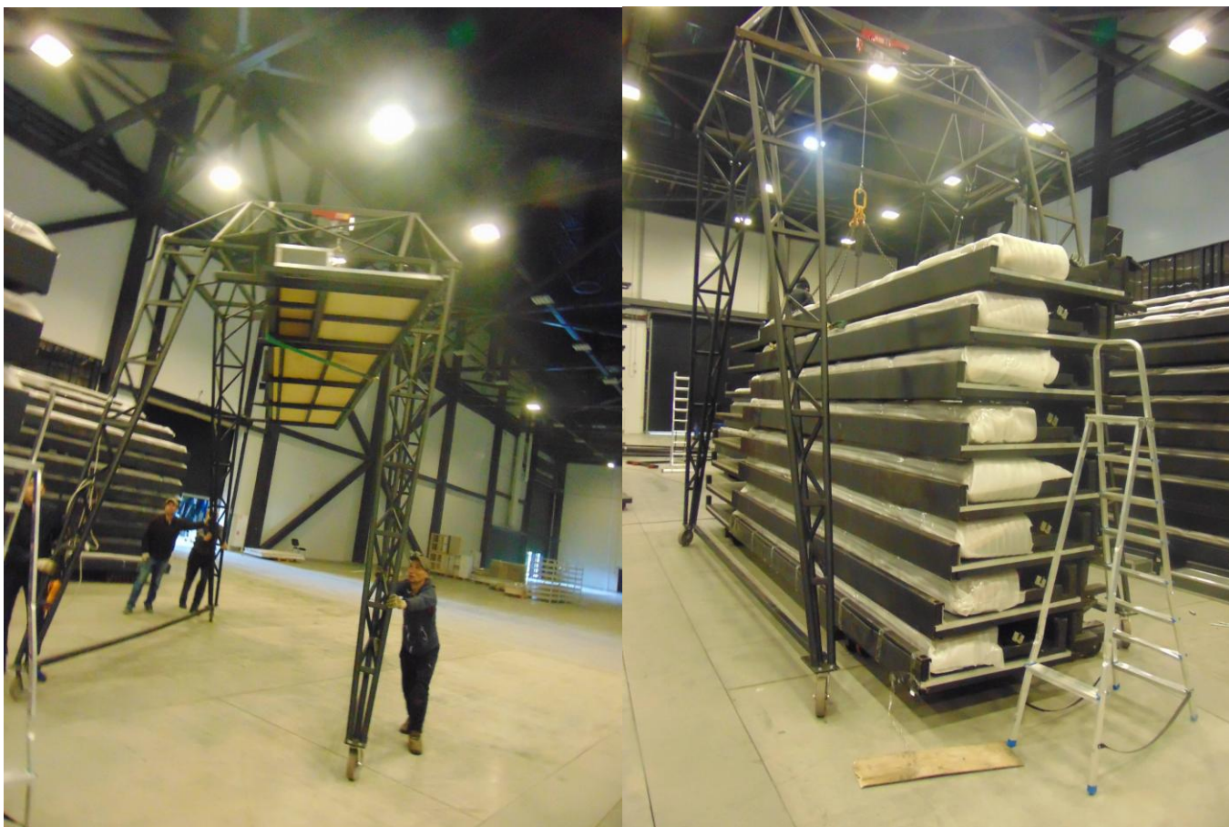
Рис. Монтаж телескопического модуля трибуны производится с использованием специально разработанного и изготовленного мобильного козлового крана-манипулятора с электромеханическим тельфером, грузоподъемностью до 1т. При этом осуществляется захват несущей панели (лотка) с места складирования и ее монтаж в корпус модуля блитчера.
