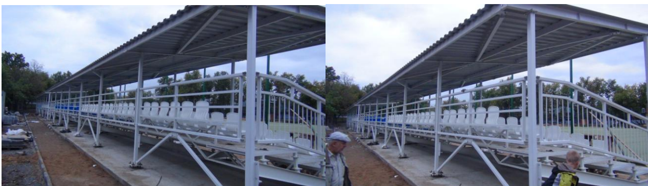
Рис. Стадия монтажа трибун на объекте.
