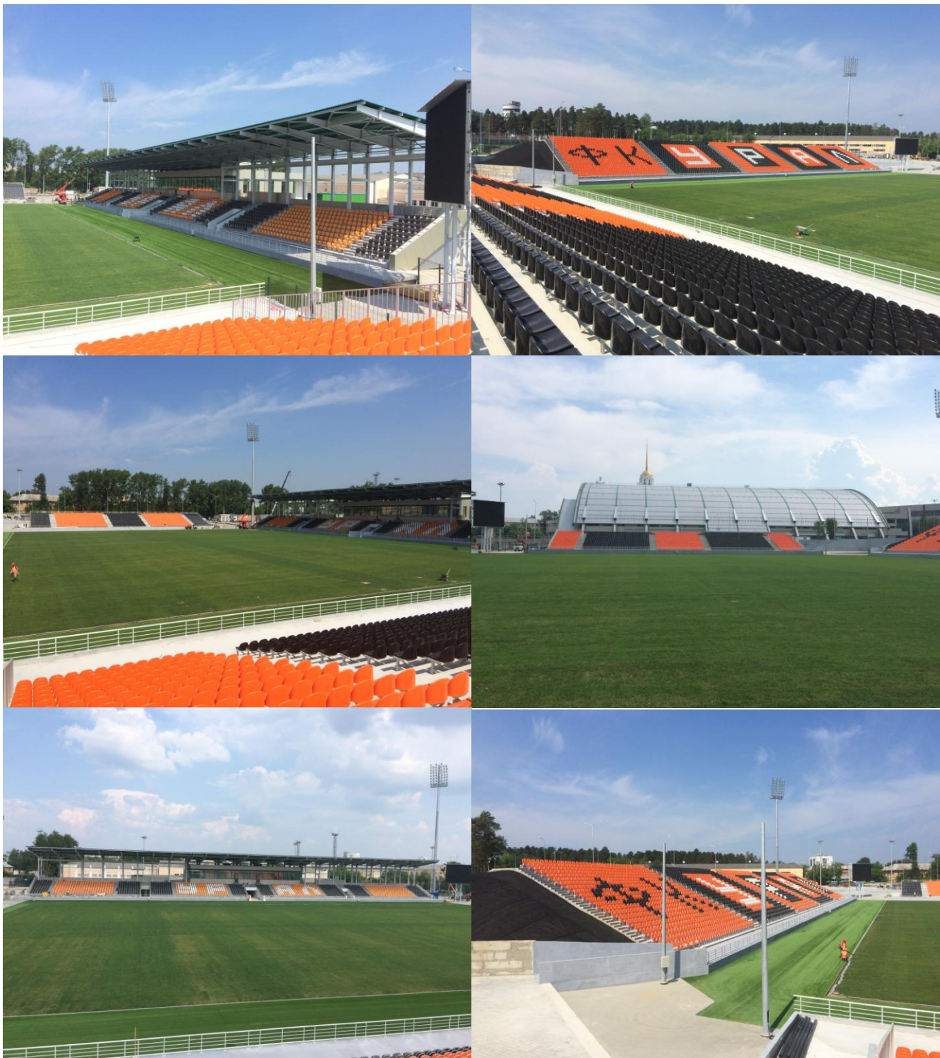
На стадии монтажных работ трибун зрительских стационарных
