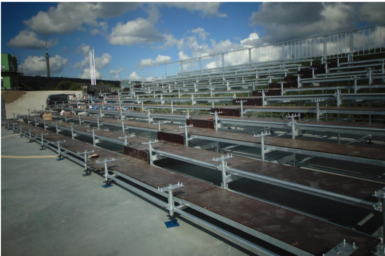
Рис. Трибуна на этапе сборки (не установлены кресельные рамы и кресла)
