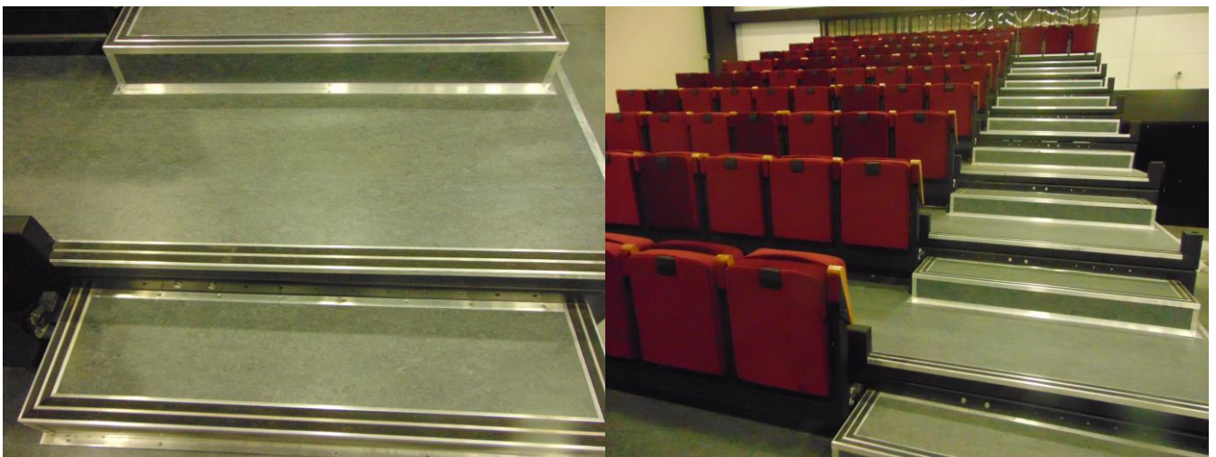
Рис. Лестничные марши трибуны (блитчера) отделаны алюминиевым профилем с противоскользящей резиновой вставкой.
