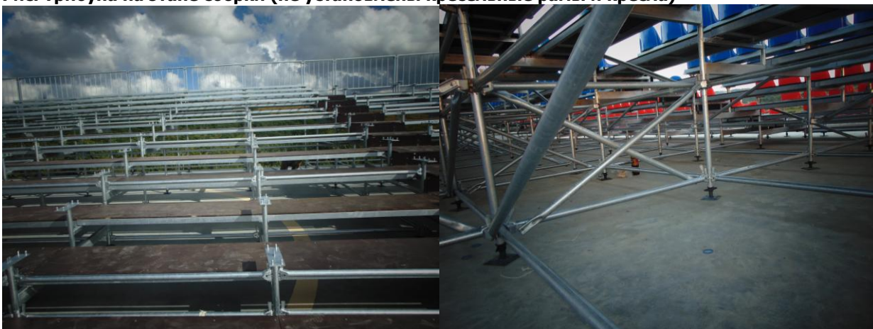
Рис. Трибуна на этапе сборки (не установлены кресельные рамы и кресла)
