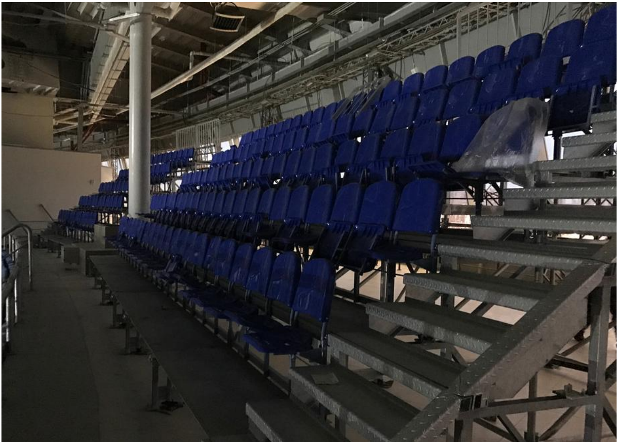
Трибуна на этапе монтажных работ
