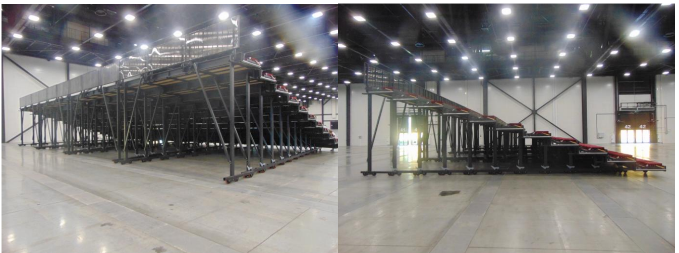
Рис. Три модуля трибун телескопических выстроены в ряд
